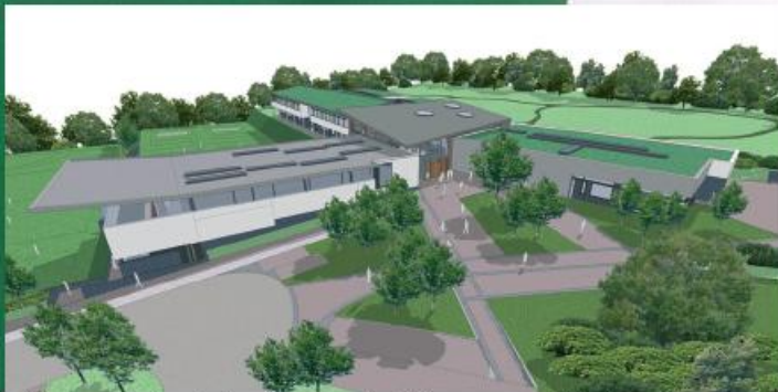
Nuevas instalaciones de Rosemont School
